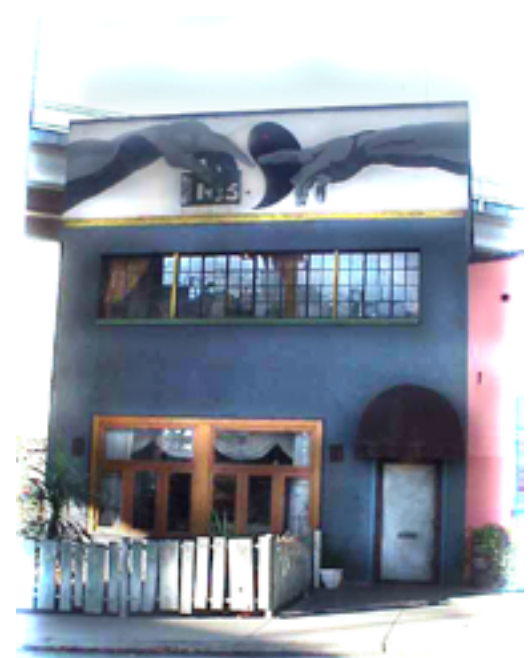
L'Espace sous le pont Status: Demolished
